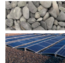
Flachdach Rundkies 8/16, PV-Anlage im Modulsystem auf Flachdach (Contracting-Modell)
