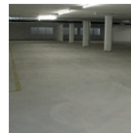
Bodenbelag Asphaltbelag, Entwässerung mittels Bodenabläufe und Rinnen oder Einlaufschächte
