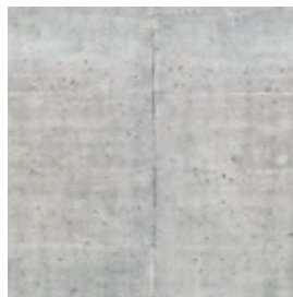
Wände und Decken Beton roh
