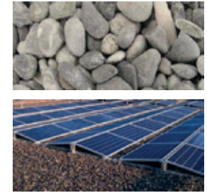
Flachdach Rundkies 8/16, PV-Anlage im Modulsystem auf Flachdach (Contracting-Modell)
