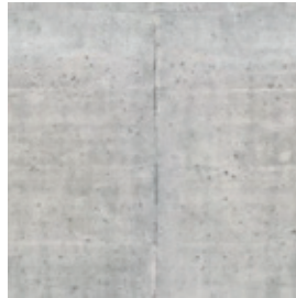
Wände und Decken Beton roh
