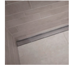
Dusche Boden Feinsteinzeug im Gefälle mit integrierter Rinne z.B. Typ Cleanline Fa. Geberit Duschtrennwände in Klarglas
